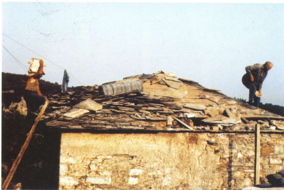
135. Ο Σταύρος Κορνούτος και ο βοηθός του επισκευάζουν μια πληγορέϊτικη στέγη. (Φωτ. 1979).
