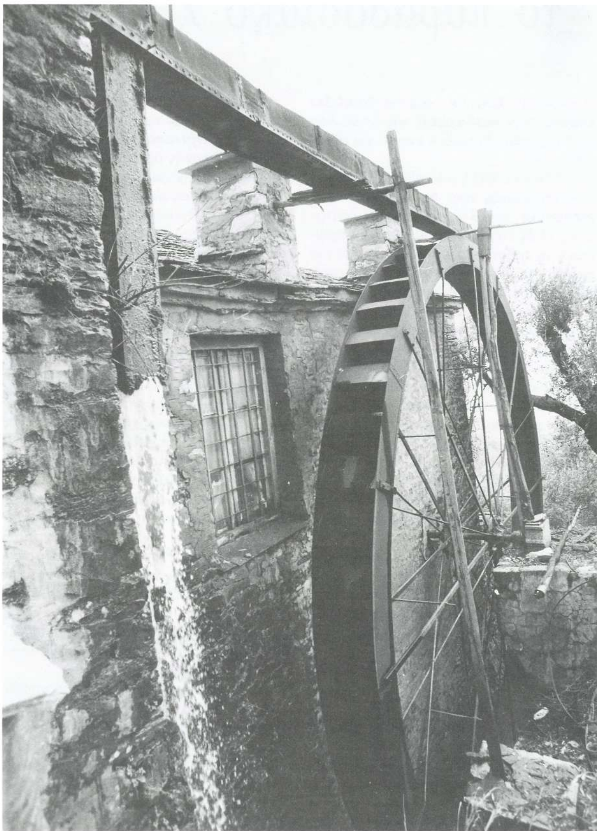
121. Η φτερωτή, εξωτερική ρόδα στο λιοτρίβι, που γυρίζει με τη δύναμη του νερού. (Φωτ. 1983).
