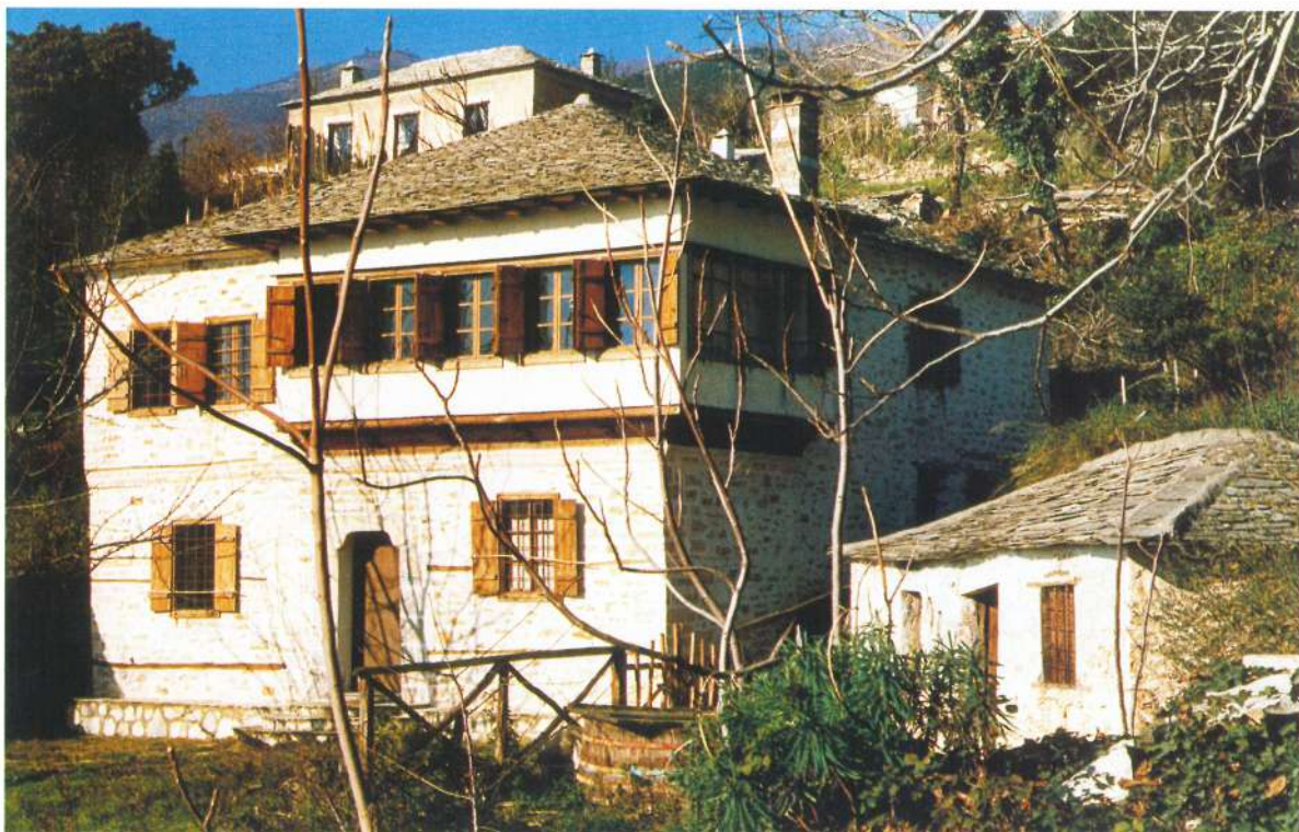
111. Το σπίτι της οικογένειας Βαρελάκη. Εξαίρετο δείγμα αποκατάστασης παραδοσιακού κτιρίου από τοπικούς τεχνίτες. (Φωτ. 1987).
