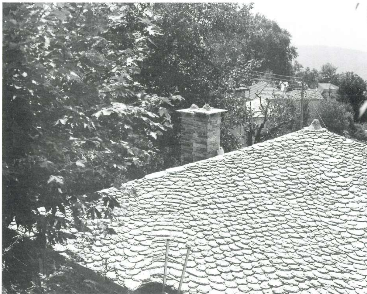
137. Δείγμα πηλιορείτικης στέγης, σκεπασμένης με πλάκες. Οικία Σακελλαρίου. (Φωτ. 1984).
